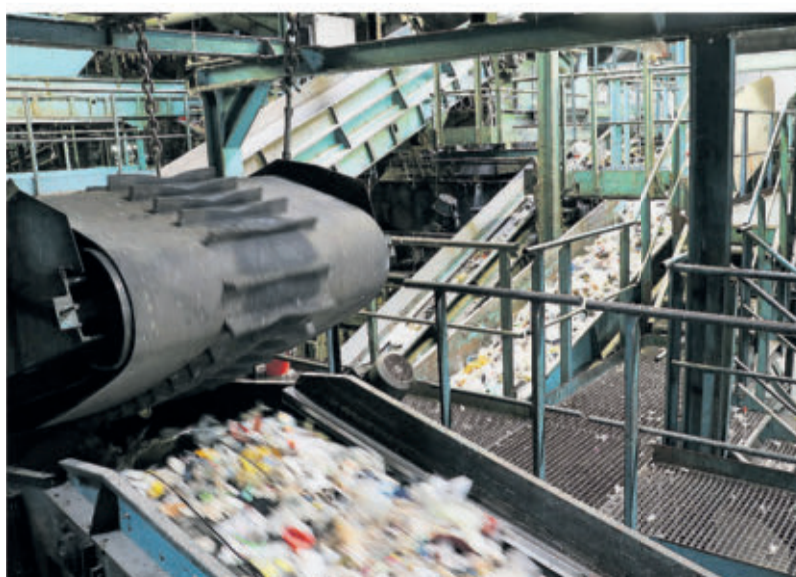
Auf den Bändern werden die verschiedenen Materialien zu Scannern, Sieben oder Magneten transportiert.
